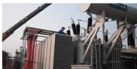
Бангладеш: силовой трансформатор для Aggreko
