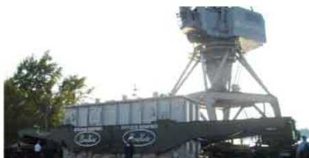
Сербия: трансформатор 400kV 400MVA
